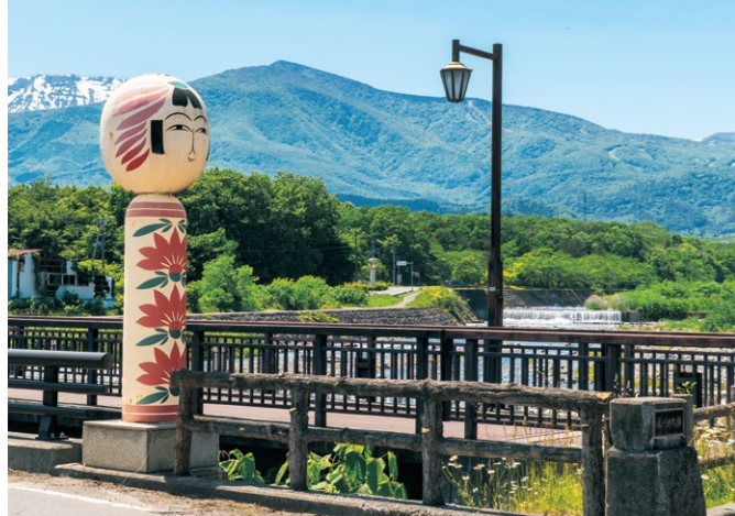
蔵王連峰を望む遠刈田大橋は「こけし橋」の愛称で親しまれている
