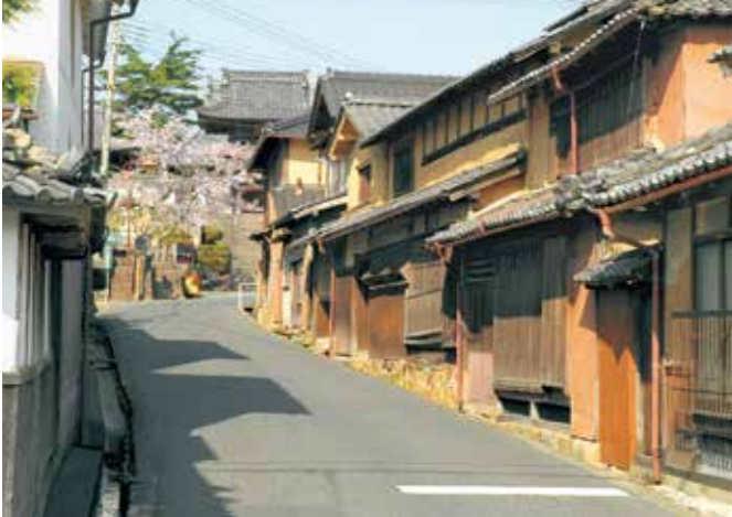
与謝野町のちりめん街道には、明治時代から続く織物工場や町屋が建ち並ぶ
