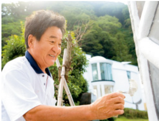
「28～30cm四方の瓦を焼いて壁に貼り付け、そのつなぎ目に漆喰を盛り上げる。端っこを決めるのが本職」と中村さん。
