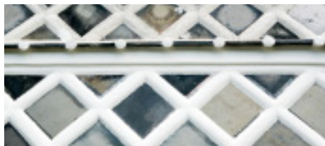
「28～30cm四方の瓦を焼いて壁に貼り付け、そのつなぎ目に漆喰を盛り上げる。端っこを決めるのが本職」と中村さん。
