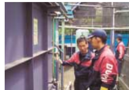
廃水処理設備の点検。
