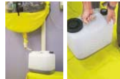
エアコンクリーニングの汚水はポリタンクに入れて店に持ち帰って処理します。
