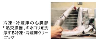
冷凍・冷蔵庫の心臓部「熱交換器」のホコリを洗浄する冷凍・冷蔵庫クリーニング
