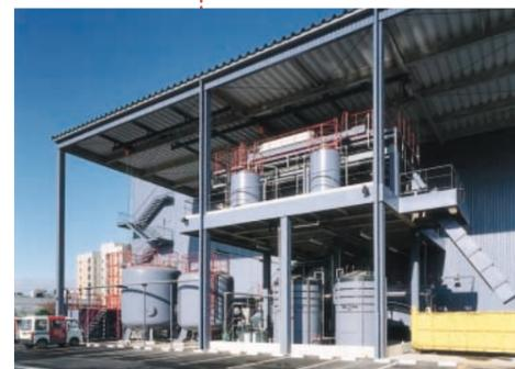
廃水処理施設。商品の洗浄に使用した汚水は、処理施設で細かなホコリや汚れを取り除き、魚がすめるほどキレイな水に戻して放流
