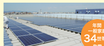
大阪中央工場屋上
