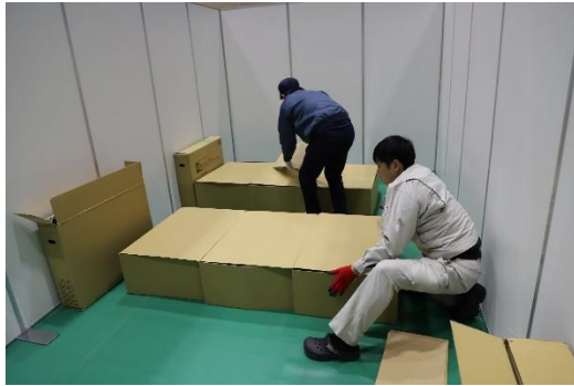
避難所設営の様子
