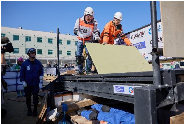
2 階部分の畳を取り除く
