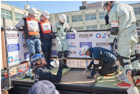
ノコギリで 2 階部分の床板に開口をあける
