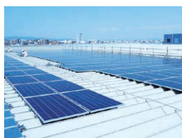
大阪中央工場屋上
