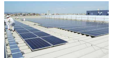
大阪中央工場屋上
