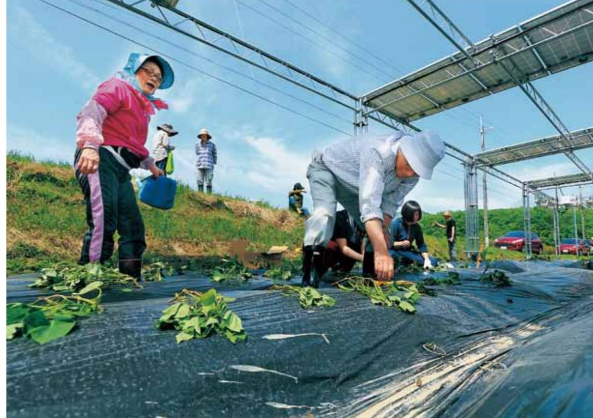
ソーラーシェアリングの市民農園「KOYOSHI農園」。藤棚のような架台の上部約3分の1をソーラーパネルが覆って発電し、その間からふり注ぐ太陽光で農作物を栽培する
