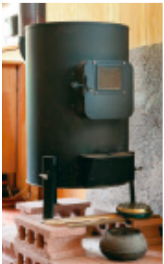
薪を太いまま放り込める大きなストーブ。まっすぐな煙突なのでススが出ない。
